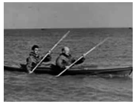
Kayak conçu par le Major Blondie Hasler, pouvant être embarqué sur un sous-marin et transporter 2 commandos et 75 kg de matériel.
